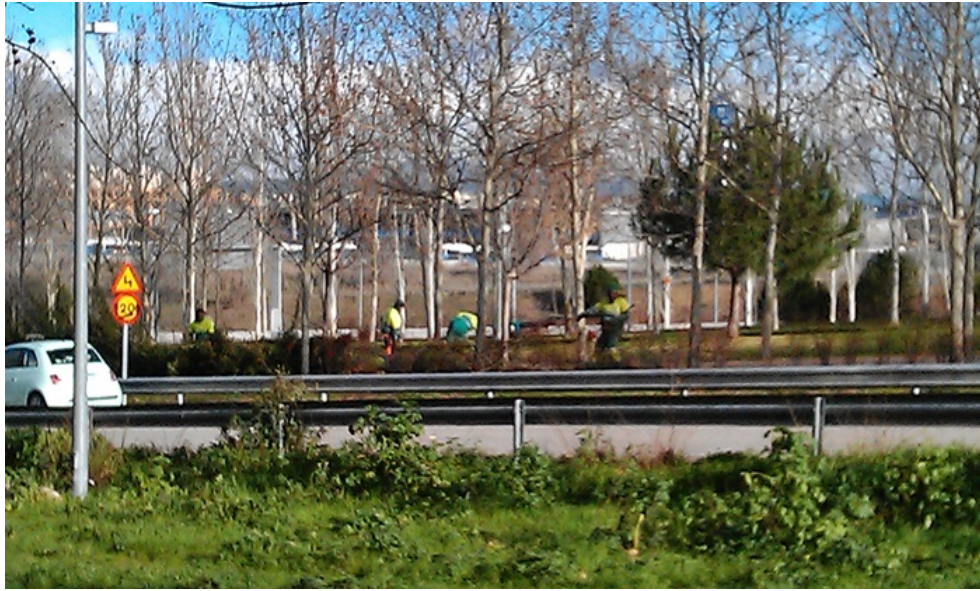
Figura 2.35: Vista de grupo de operarios
