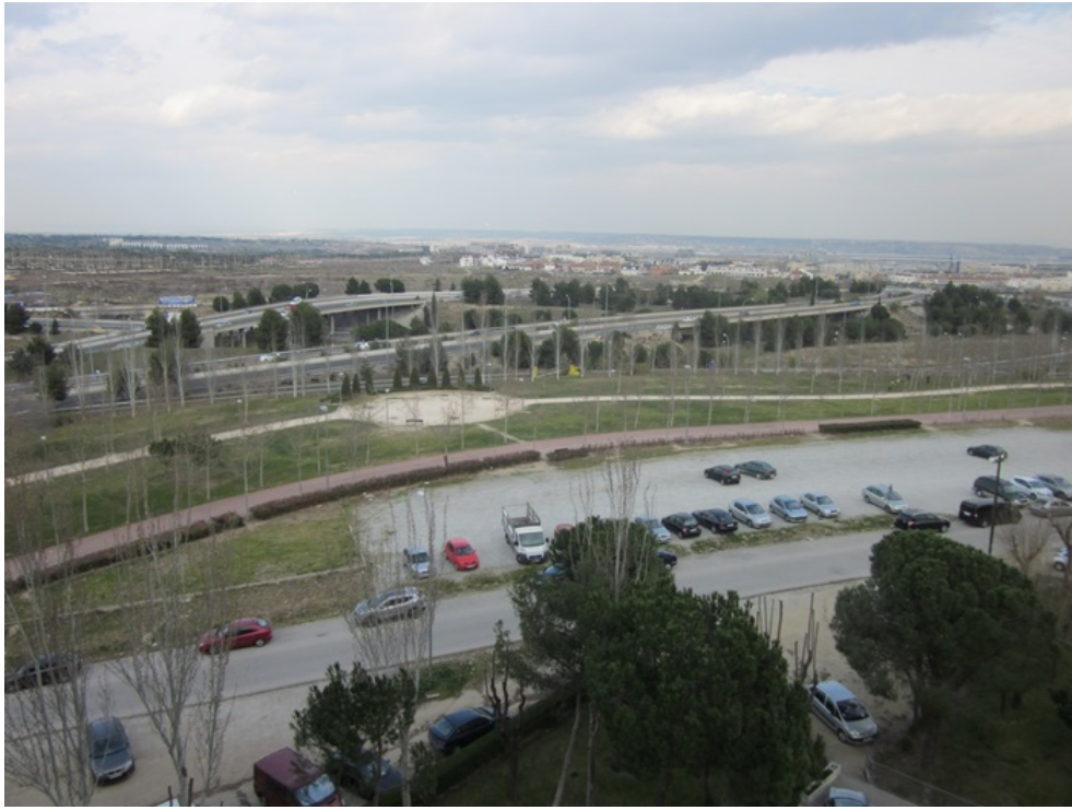
Figura 2.47: Vista general de altura
